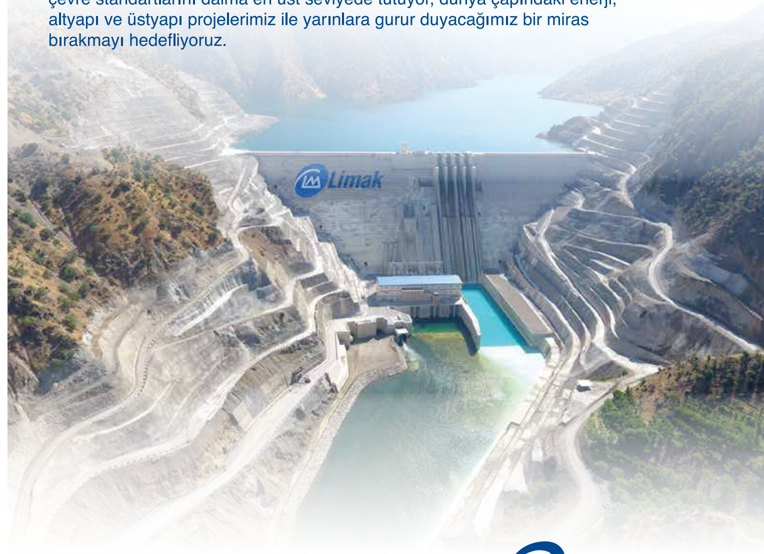
Çetin Barajı ve HES
